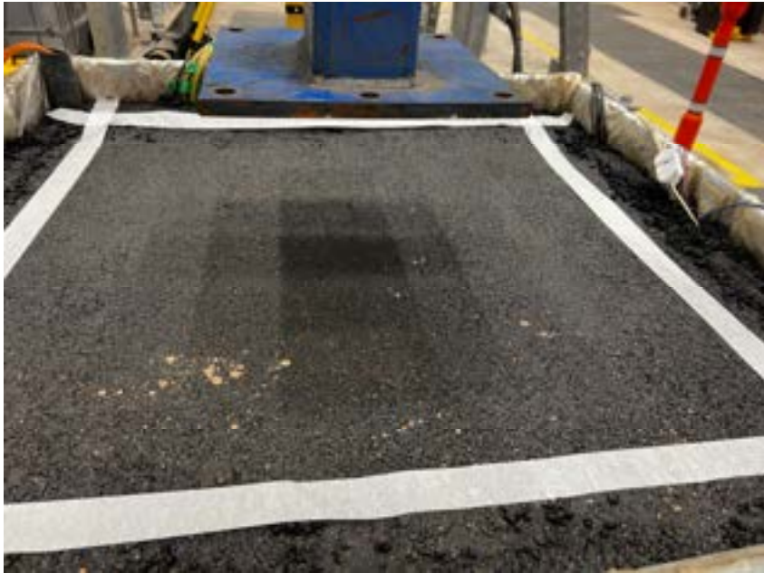
Cold pavement layer
